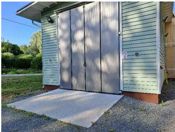
Betoniluiska laajennusosan autohallin taitto-oven edustalla
