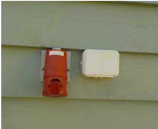
Pistorasioita ulkoseinällä
