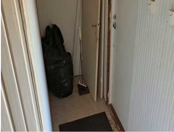
Väliovia säilössä alkuperäisillä osalla
