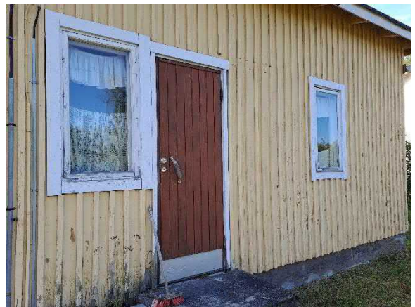
Alkuperäisen osan ikkunoita ja ovi itäjäulkisivulla
