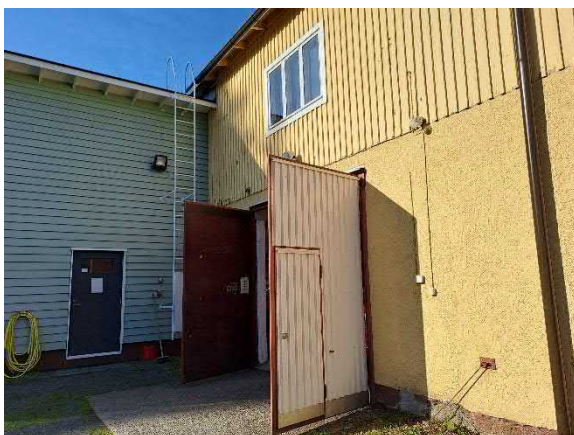
Betoniluiska alkuperäisen osan autotallin ovien edustalla
