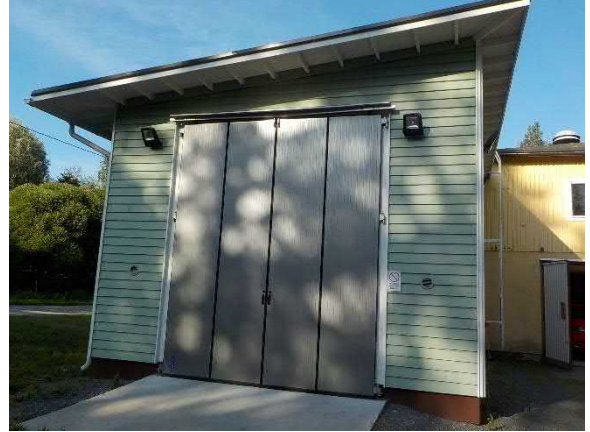
Laajennusosan autotallin taitto-ovi
