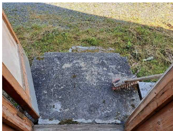
Betoniporras alkuperäisellä osalla
