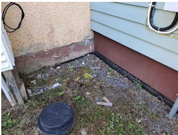
Laajennusosalla salaojan tarkastuskaivo, sade- vesien ohjaus rakennuksen vierustalle
