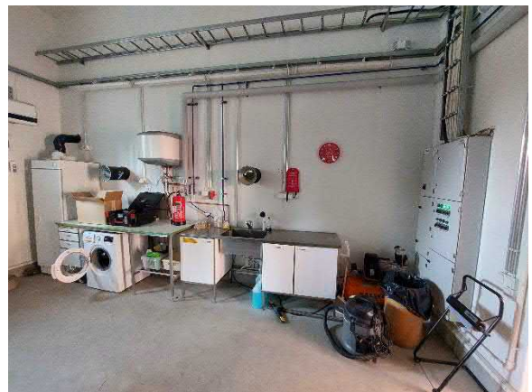
Yleiskuva alakerran kalustohuoltotilasta
