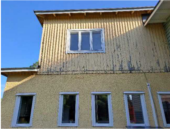
Alkuperäisen osan ikkunoita länsijulkisivulla
