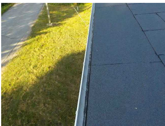
Sadevesikouru laajennusosalla siistissä kunnossa
