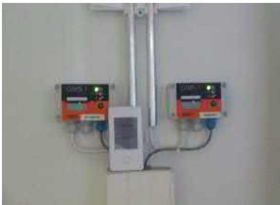
Öljyn/hiekanerotuskaivon hälytyskeskuksien sähköistystä
