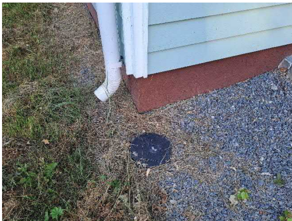
Laajennusosalla salaojan tarkastuskaivo, sade- vesien ohjaus rakennuksen vierustalle
