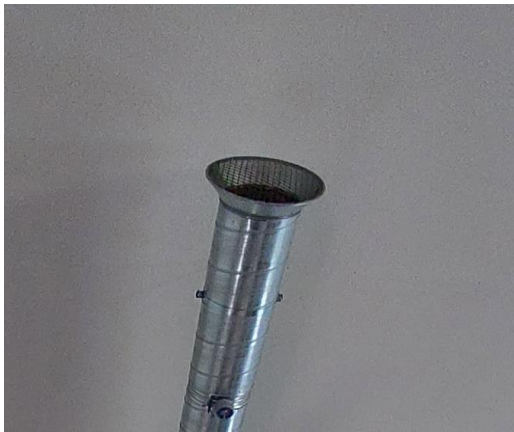
Laajennusosan poistoilmapäätelaite.
